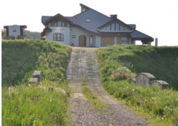
Fot. 4. Zabudowa suburbanizacyjna w otulinie ŚPN – zabudowa wraz z mostkiem wjazdowym budynek przy Drodze Kakonińskiej – nr 0599 (Fot.: M. Strzyż, 2019)
